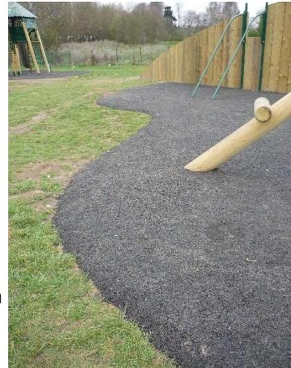
Pro Base Pads™ s'installent directement sur le sol sans excavation supplémentaire, et lorsqu'ils sont utilisés avec le paillis de caoutchouc collé Ecosurface, ils ne nécessitent aucun matériau de bordure ou de bordures définies.
