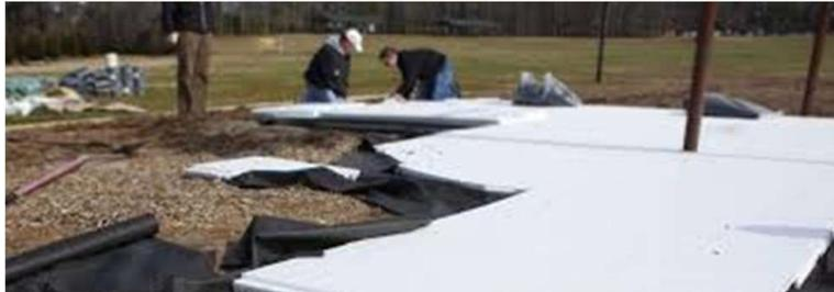
Pour plus de clarté, nous n'utilisons les shockpads que dans de très rares circonstances, car notre système de paillage en caoutchouc est généralement posé sans couche de base ni travaux de terrassement. Toutefois, en cas de besoin :
